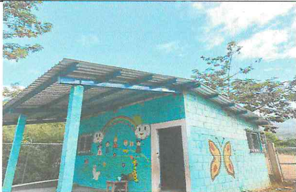
FOTO 1: ESTRUCTURA Y CUBIERTA DEL AULA INSTALADA.
