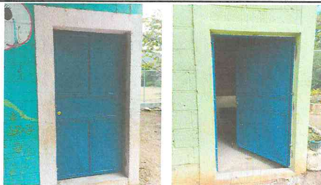
FOTO 3: INSTALACIÓN DE PUERTAS
