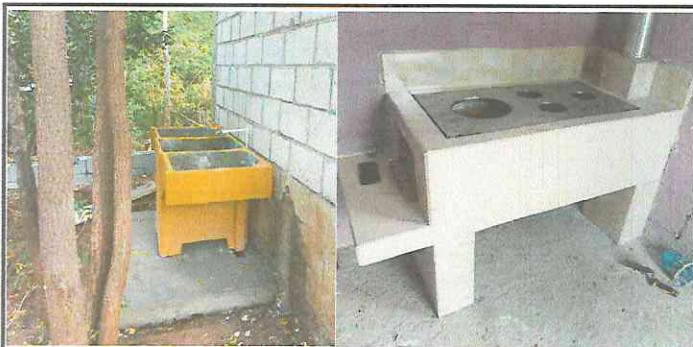
FOTO 5: INSTALACIÓN DE PILA DE DOS LAVADEROS Y ESTUFA RURAL CON CHIMENEA TERMINADA.
